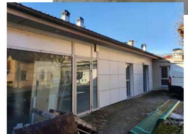
→ Fam Sous La Roche A Talissieu, les travaux se poursuivent : les résidents pourront bientôt profiter d'un espace bien-être et balnéo !
